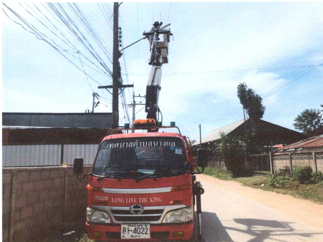
ภาพถ่าย การซ่อมแซมไฟฟ้าสาธารณะประจำปีงบประมาณ 2564
